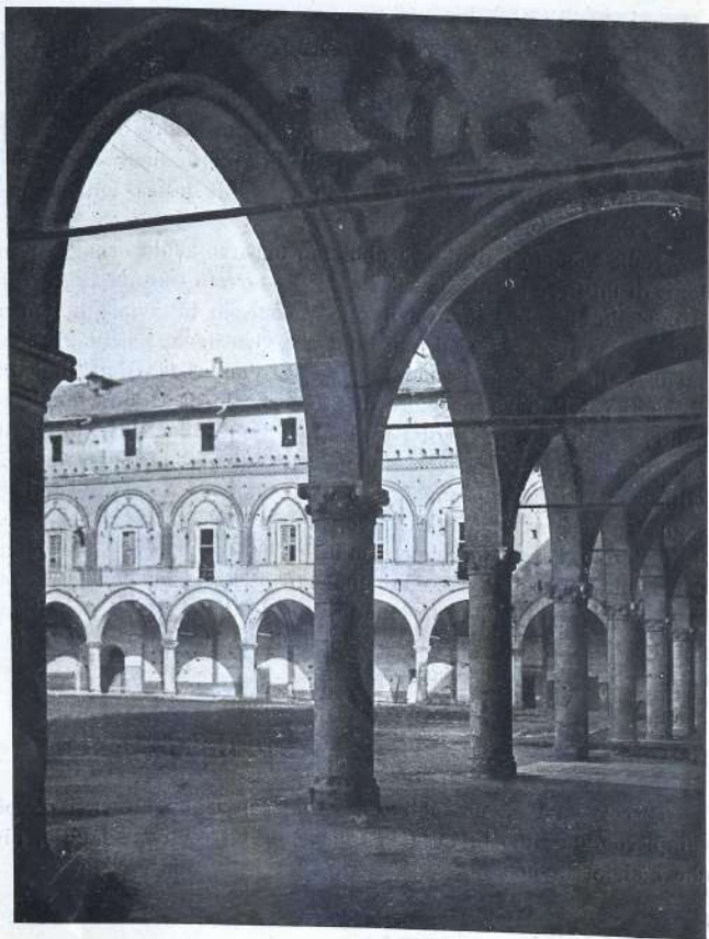
Fig. 13. — Riapertura dei porticati.
