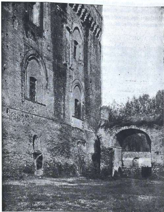
Fig. 21. — Il Castello nello stato in cui era prima dei restauri.
