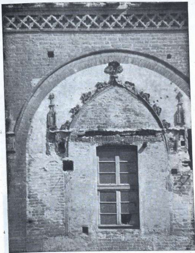
Fig. 16. — Stato delle monofore prima dei lavori di liberazione.
