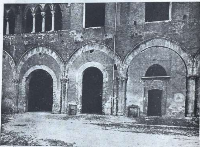
Fig. 11. — Assaggi per rimettere in luce le colonne dei porticati.
